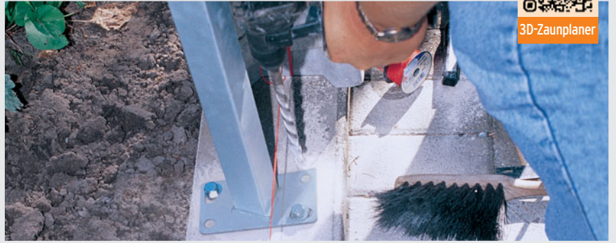
oder mit Pfostenträger aufschrauben.
