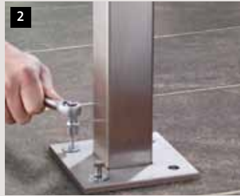
2 Pfosten ausrichten und montieren.
